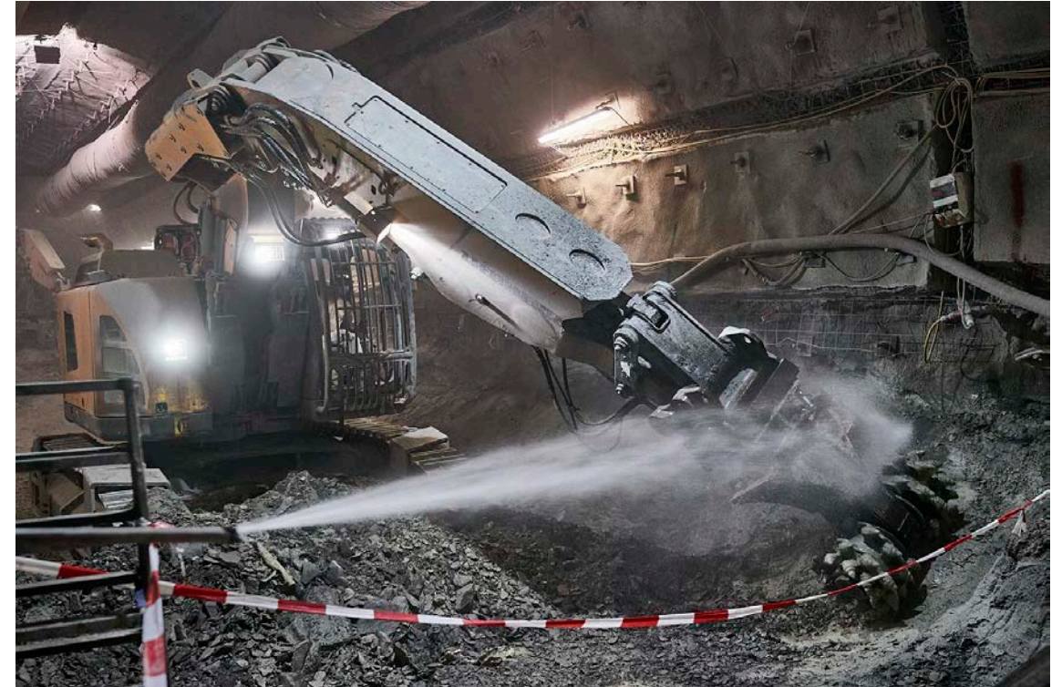
Der Ausbau erfolgt in Etappen, je nach Streckendurchmesser, mit Gesteinsfräsen, Hydraulikmeißeln oder Teilschnittmaschinen.
