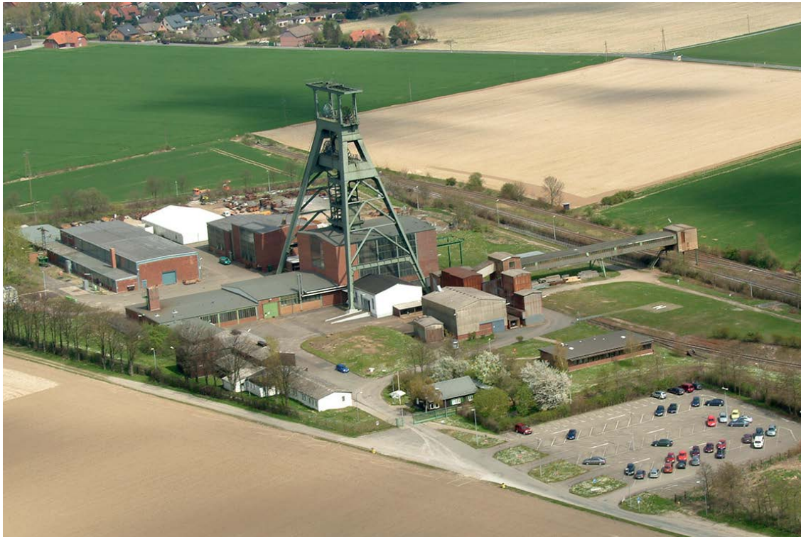
April 2008: Schachtanlage Konrad 1 vor dem Beginn der Umrüstarbeiten.
