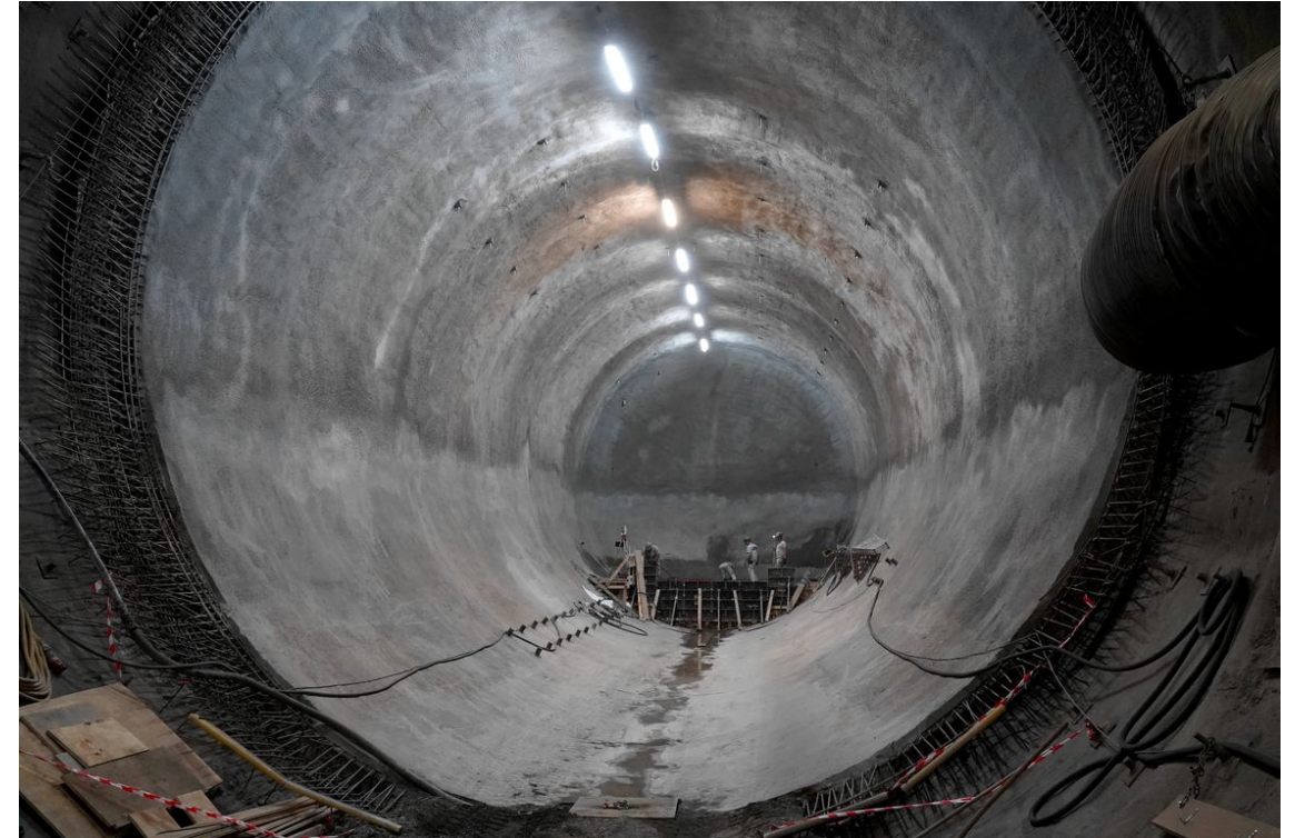
Beispiel für endgültigen Röhrenausbau – hier entsteht später ein Waschplatz im Bereich der Baustoffanlage unter Tage.
