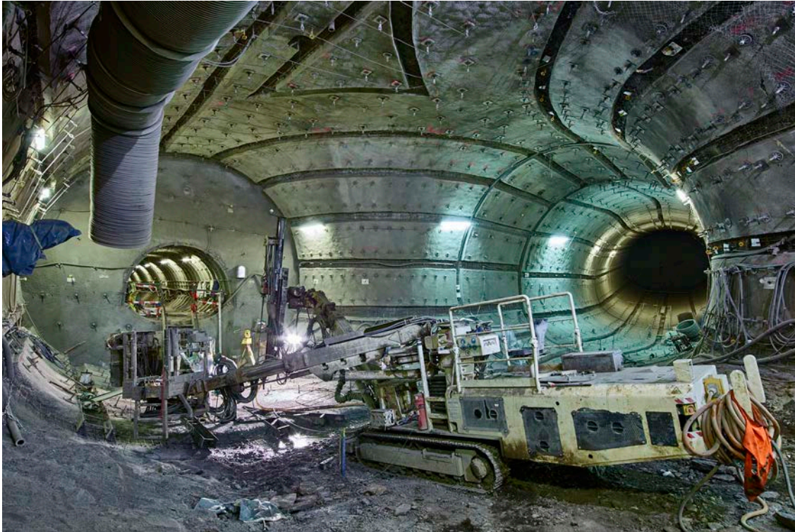
Blick in die Einlagerungstransportstrecke – hier entlang werden später die Behälter mit den radioaktiven Abfällen transportiert.
